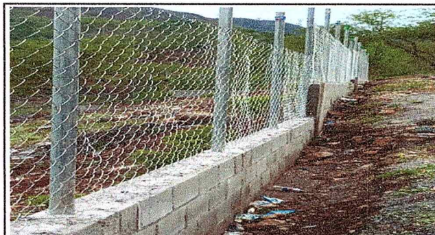
Foto 4: Instalacion del muro perimetral finalizado
