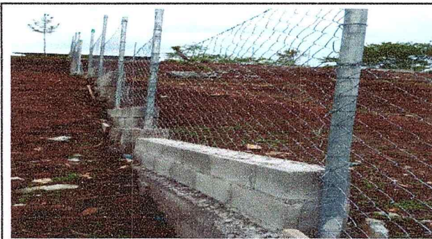
Foto 3: Instalacion de block, tubo galvanizado y malla finalizado.
